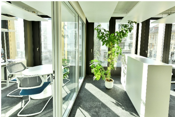
Ausbau Büro im 1. OG (Metall-Akustik/Klima-Deckensegel)
