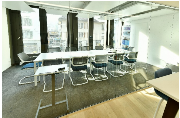
Ausbau Sitzungszimmer im 1. OG (Glas-Systemwand profillos)
